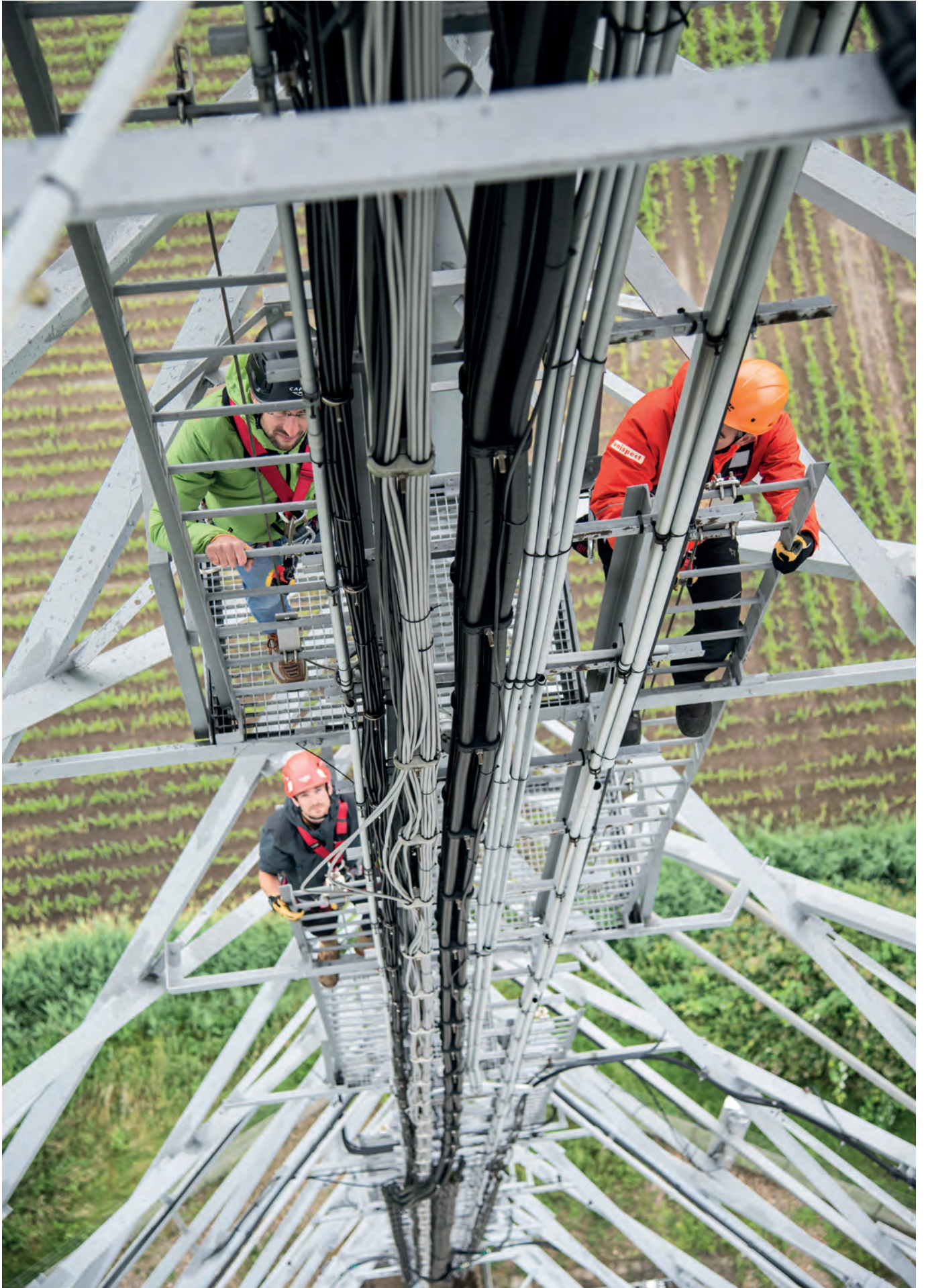
Status inspection of a shared NOVEC mast. Inspección global del estado de una torre NOVEC. Dodewaard, The Netherlands (ph. Riky Felderer, courtesy of Unispect, © C.A.M.P.).
