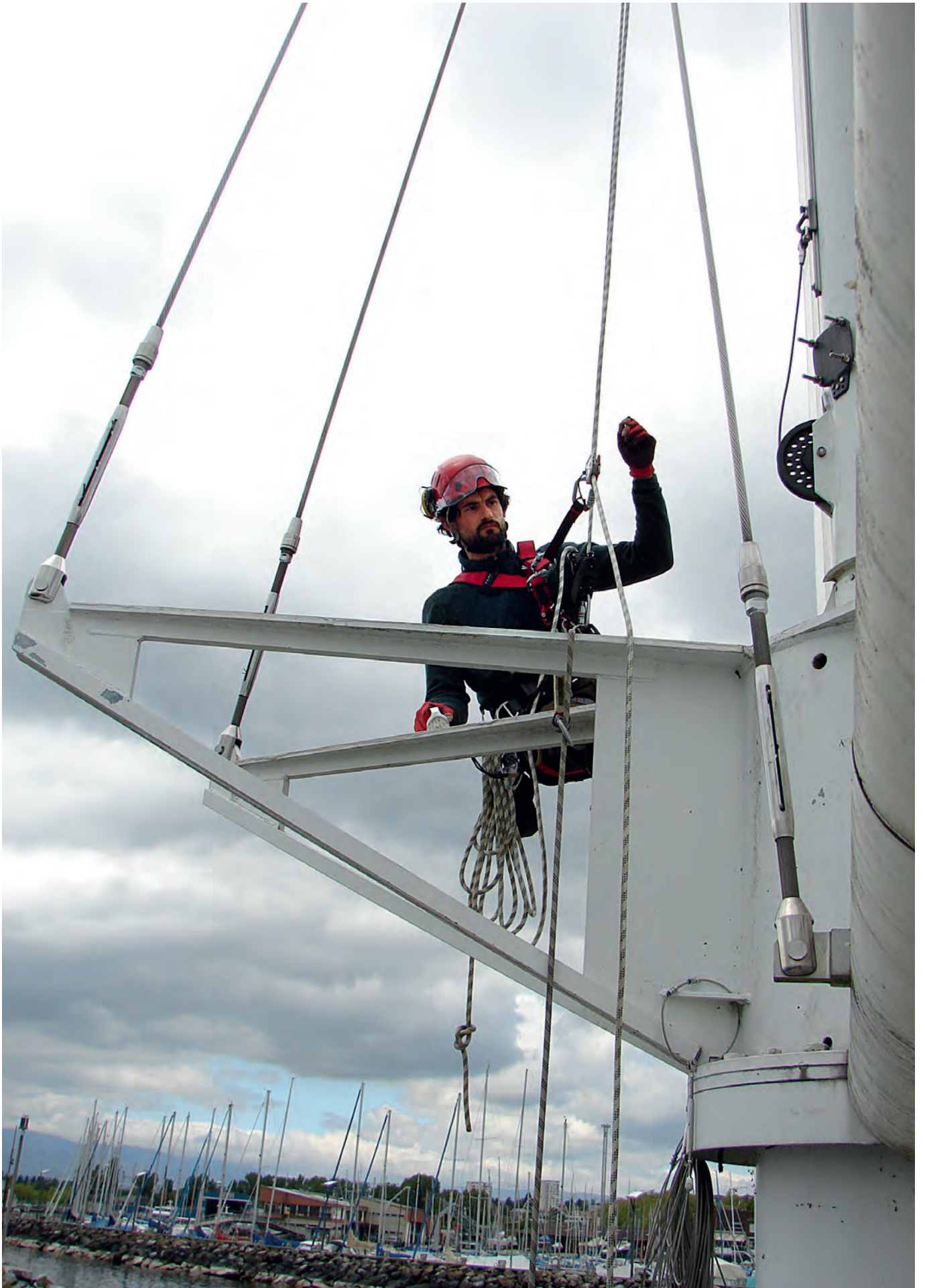
Using rope access to inspect a civil engineering structure. Acceso por cuerda para la inspección de una estructura de ingeniería civil. Ouchy-Lausanne, Switzerland (courtesy of Corde-Access SA, © Corde-Access SA).
