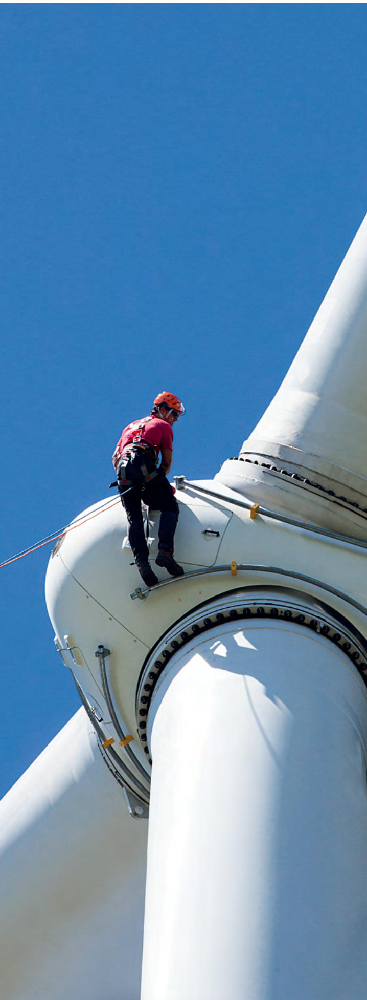
Turbine hub inspection at a wind farm. Inspección del rotor de una turbina en un parque eólico. Boulder, Colorado, USA (ph. Jack Perry, © C.A.M.P.).
